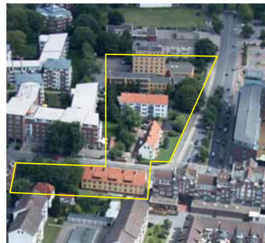
Abb. 5.2/13 Bereich für städtebauliche Neuordnung: Walsroder Straße, Höhe Konrad-Adenauer-Straße
