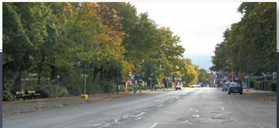
Abb. 4.3/9 Walsroder Straße mit überbreiter Fahrbahn, Querungshilfen fehlen
