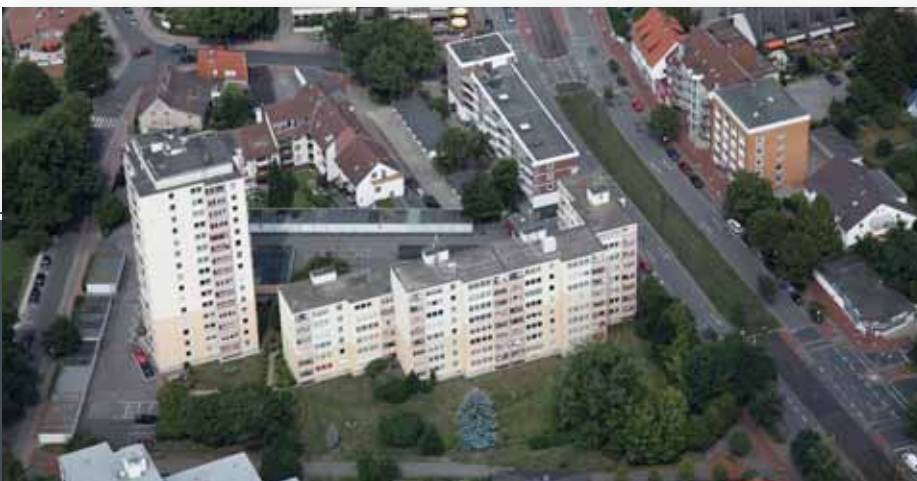
Abb. 7.1/4 Heterogene Baustrukturen im Brink, Angerstraße / Walsroder Straße
