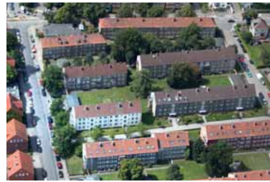
Abb. 5.2/9 Nachkriegsbauten mit überwiegend sehr hohem Modernisierungsbedarf, Bahnhofstraße
