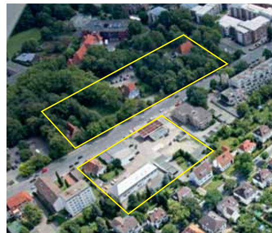
Abb. 5.2/14 Neuordnungsbereich Walsroder Straße [nördlich Lenthehof]
