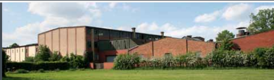
Abb. 6.2/63 Norta-Gelände von Süden von der Robert-Koch-Straße
