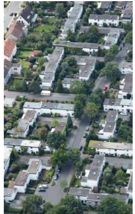
Abb.5.2/36 Reihenhäuser Bothfelder Straße in Langenhagen
