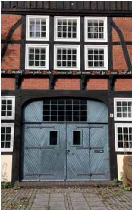
Abb. 8.2/1 Umgenutzte Hofgebäude in Godshorn
