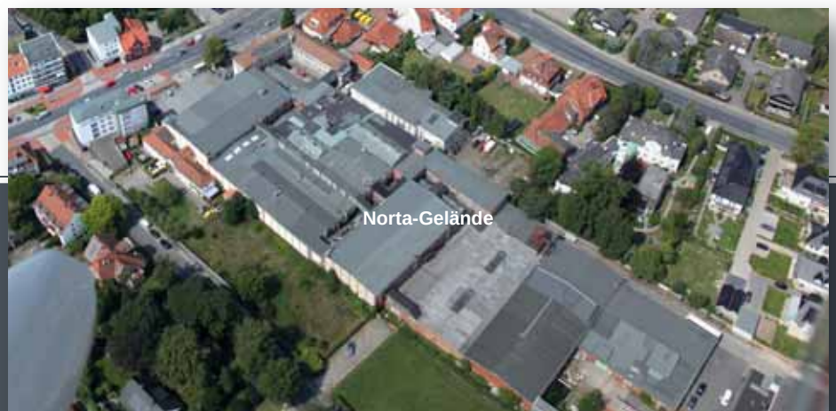
Abb. 4.2/5 Entwicklung des Norta-Geländes an der Walsroder Straße
