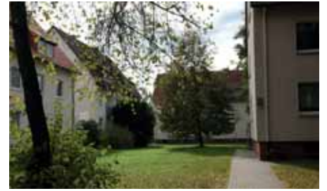
Abb. 7.4/3 Wohnsiedlung in Godshorn
