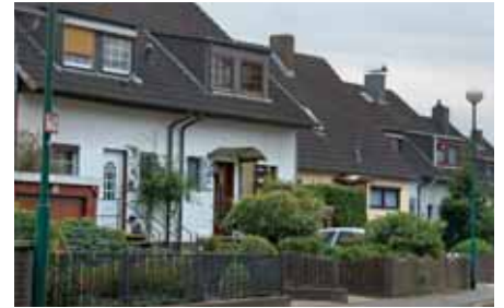
Abb. 7.3/2+3 Verschiedene Baustrukturen in Krähenwinkel
